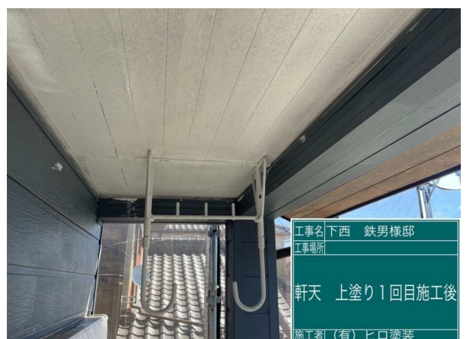
6 軒天 上塗り1回目 施工完了
