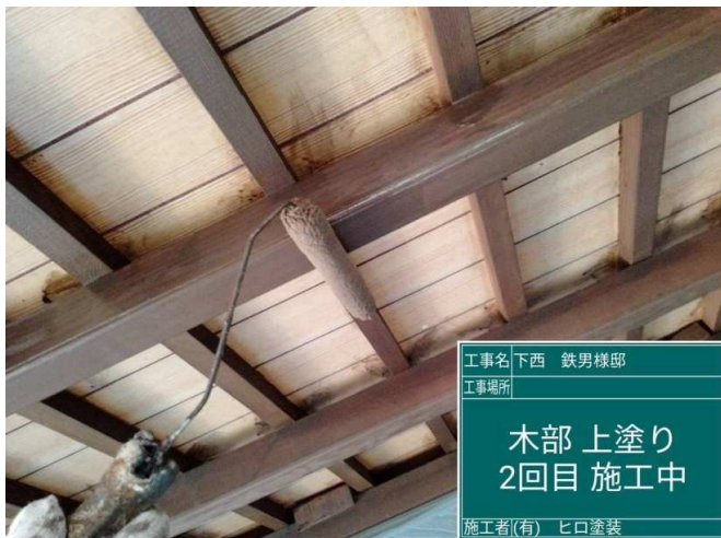
33 木部 上塗り2回目 施工中
