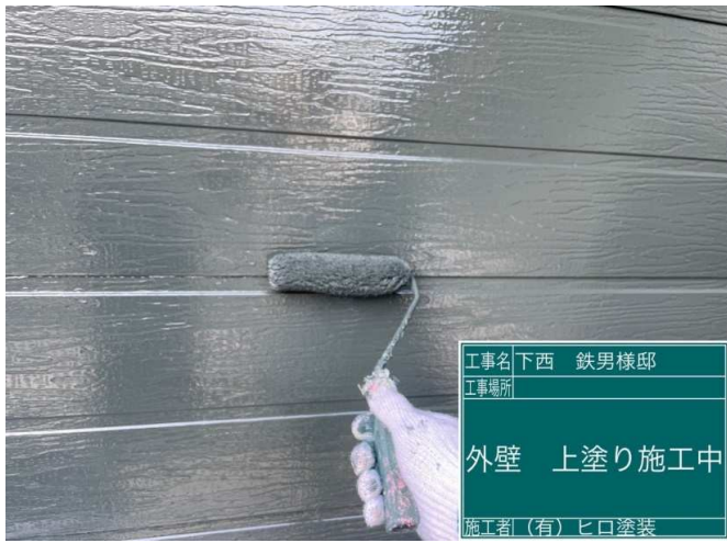
13 外壁 上塗り 施工中
