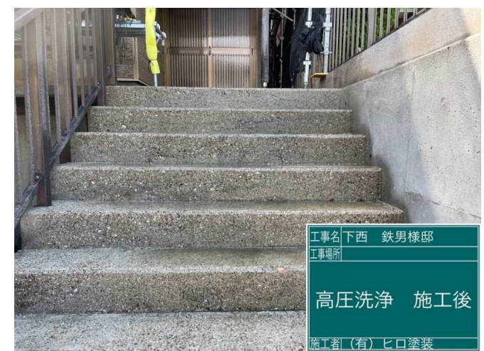
4 土間 高圧洗浄 施工完了
