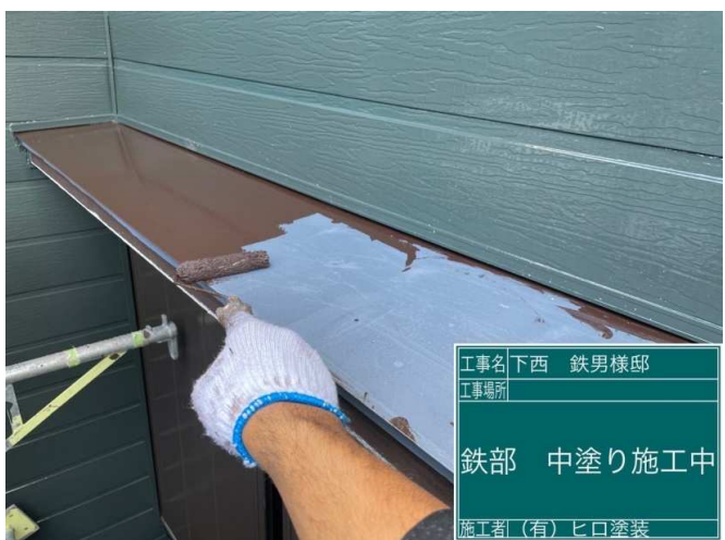
23 庇 中塗り 施工中
