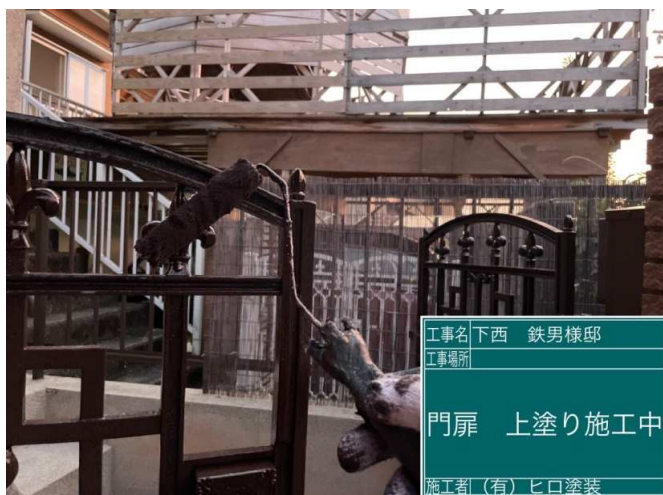
39 門扉 上塗り 施工中
