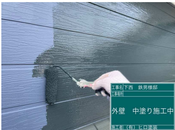
11 外壁 中塗り 施工中
