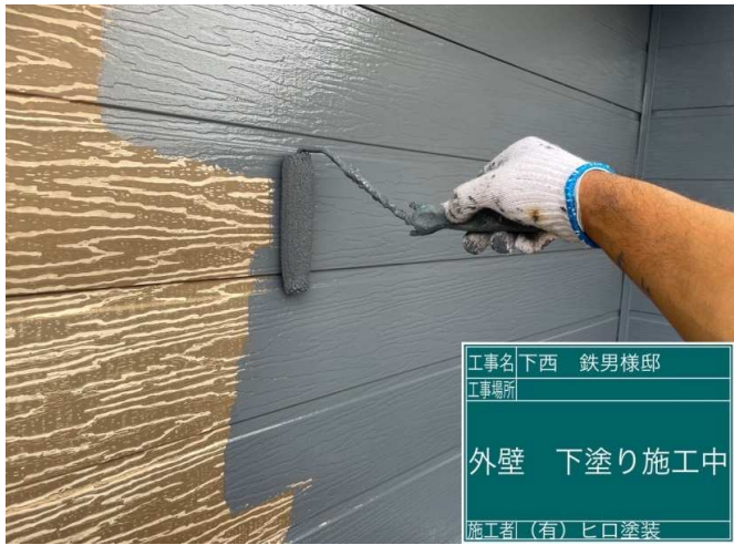
9 外壁 下塗り 施工中
