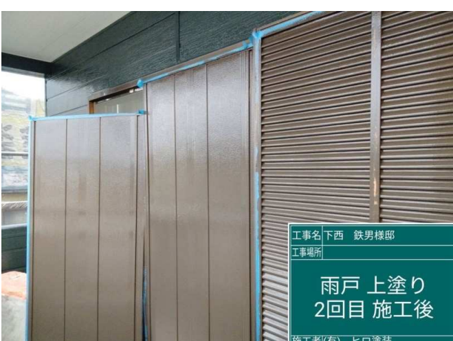
30 雨戸 上塗り2回目 施工完了
