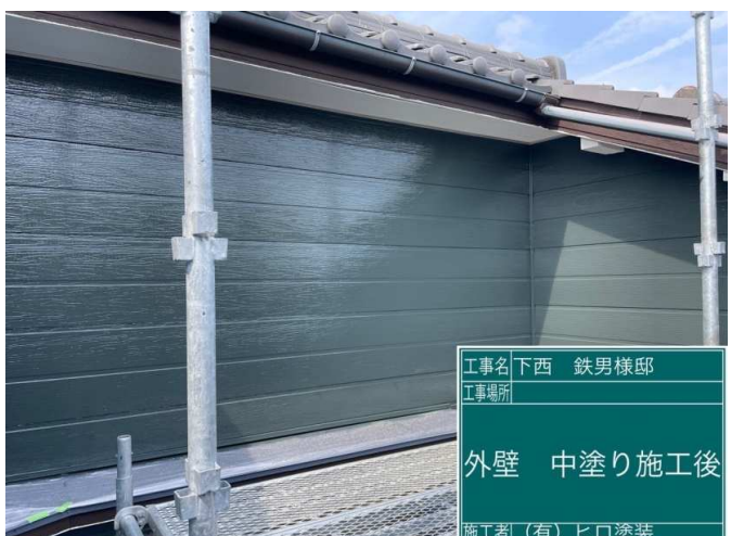
12 外壁 中塗り 施工完了
