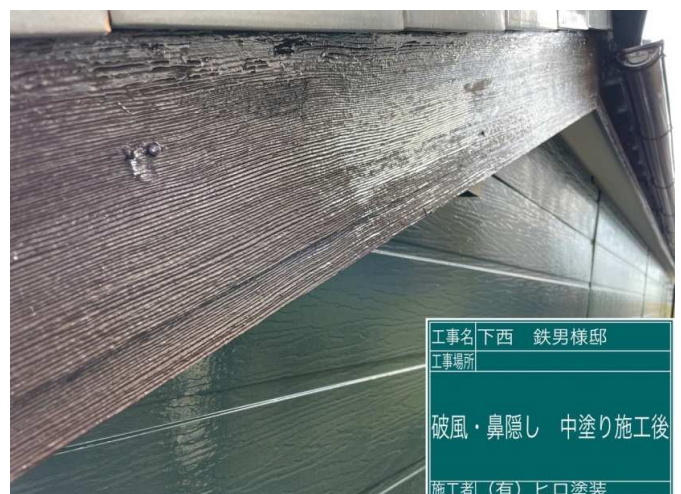
18 破風板 中塗り 施工完了
