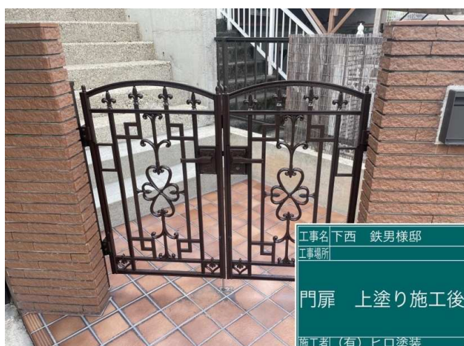
40 門扉 上塗り 施工完了
