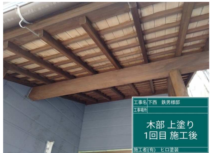
32 木部 上塗り1回目 施工完了
