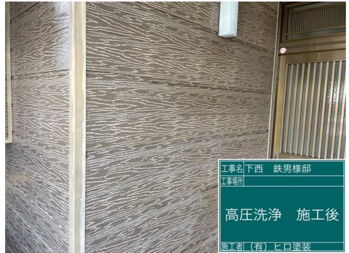
2 外壁 高圧洗浄 施工完了
