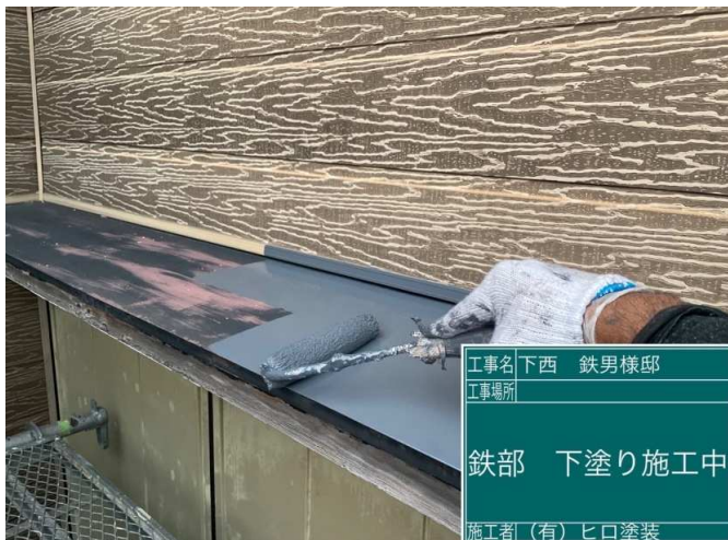
21 庇 下塗り 施工中
