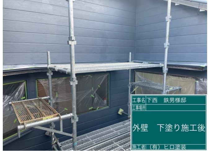
10 外壁 下塗り 施工完了
