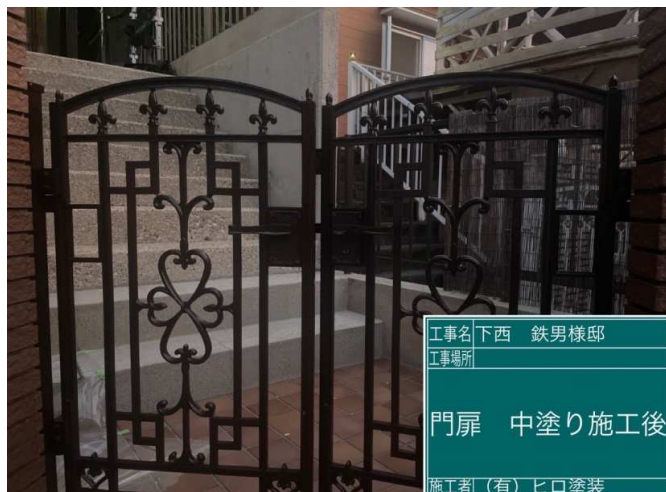
38 門扉 中塗り 施工完了
