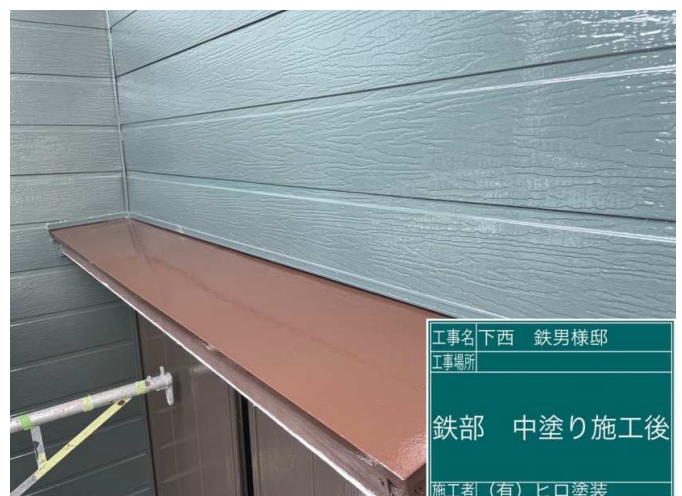
24 庇 中塗り 施工完了
