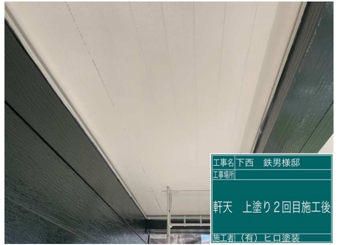
8 軒天 上塗り2回目 施工完了
