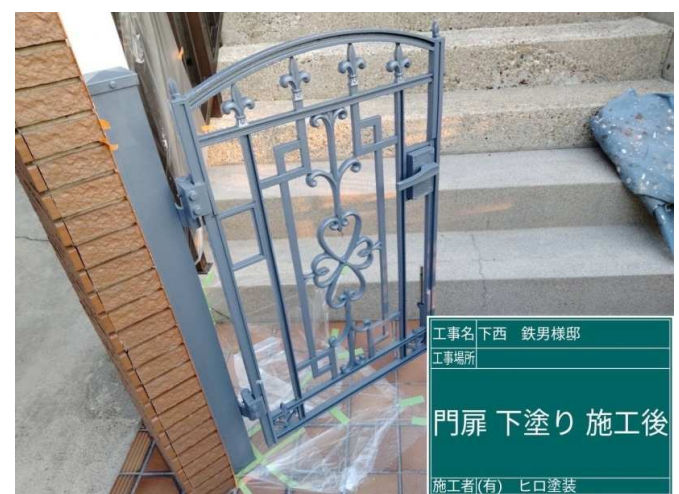
36 門扉 下塗り 施工完了
