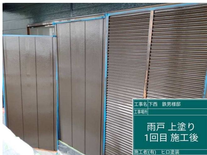
28 雨戸 上塗り1回目 施工完了
