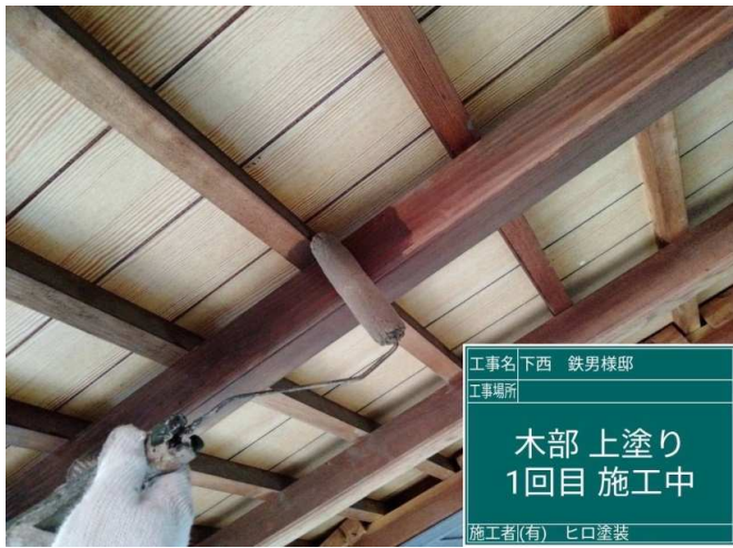
31 木部 上塗り1回目 施工中
