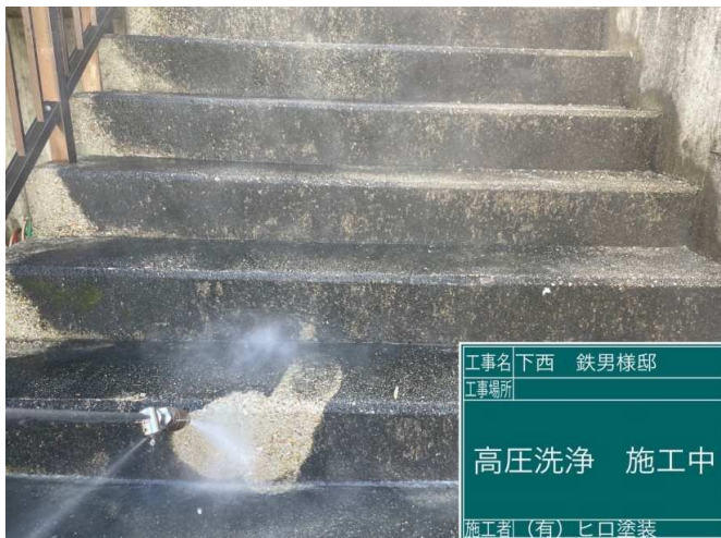
3 土間 高圧洗浄 施工中
