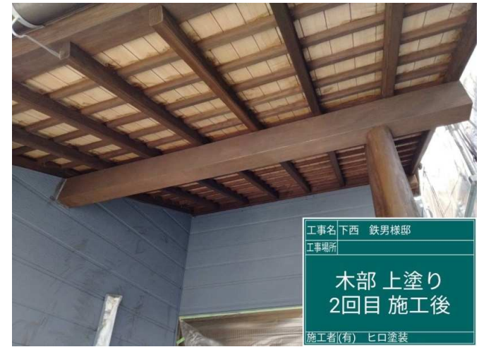
34 木部 上塗り2回目 施工完了
