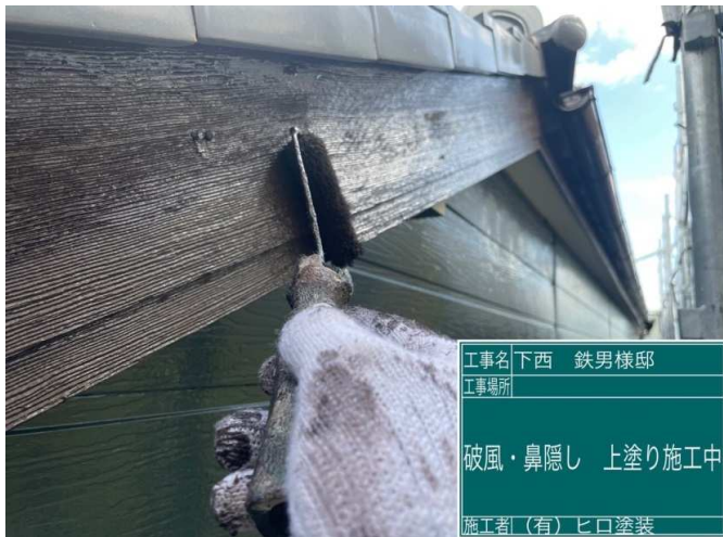
19 破風板 上塗り 施工中
