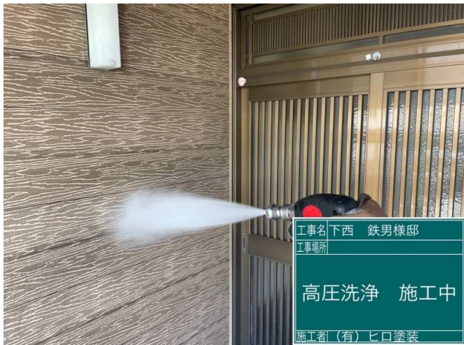
1 外壁 高圧洗浄 施工中
