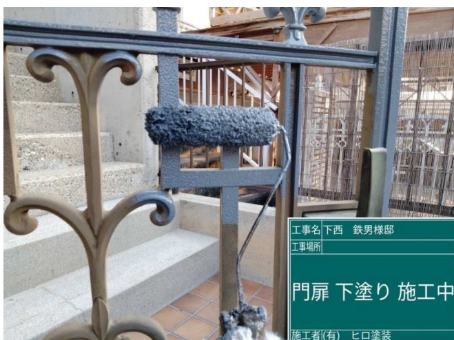
35 門扉 下塗り 施工中
