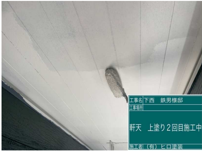
7 軒天 上塗り2回目 施工中
