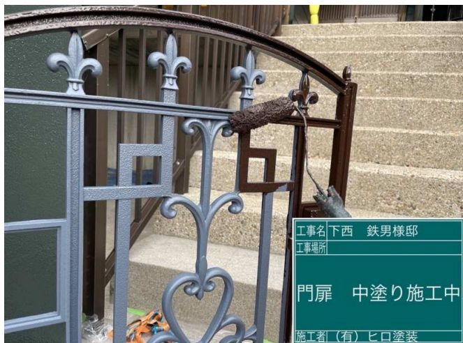
37 門扉 中塗り 施工中
