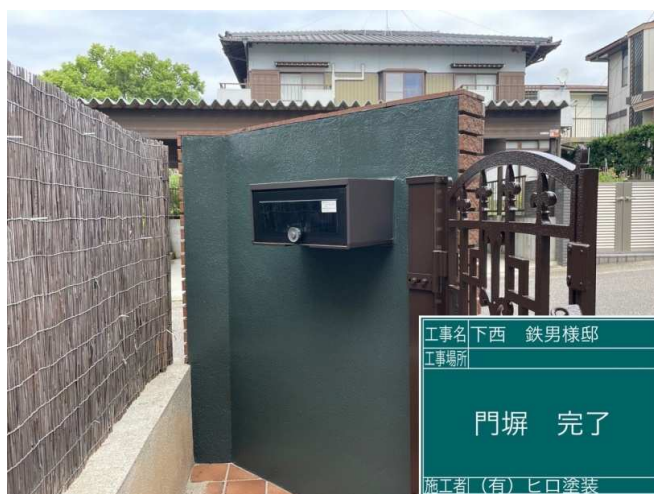
42 門扉 施工完了
