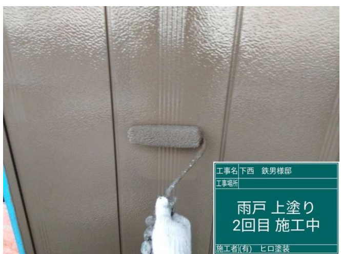
29 雨戸 上塗り2回目 施工中
