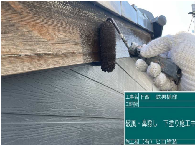
15 破風板 下塗り 施工中
