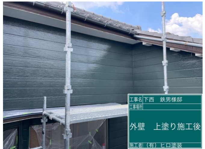
14 外壁 上塗り 施工完了
