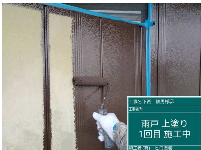
27 雨戸 上塗り1回目 施工中
