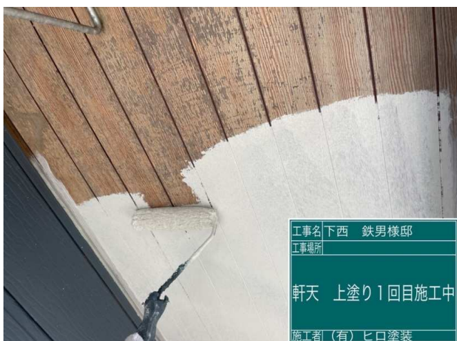
5 軒天 上塗り1回目 施工中
