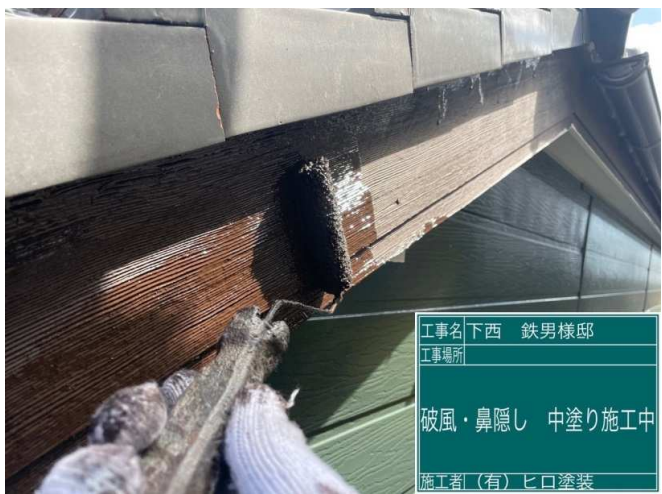
17 破風板 中塗り 施工中
