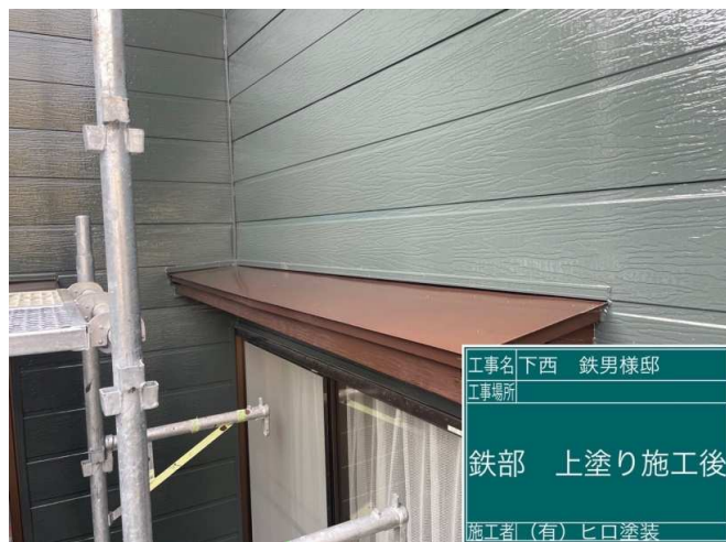
26 庇 上塗り 施工完了
