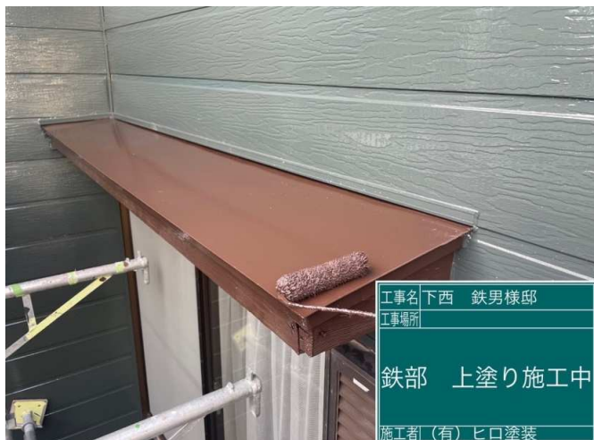
25 庇 上塗り 施工中
